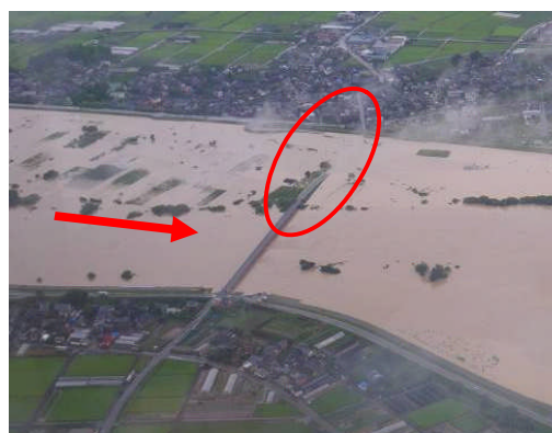
④出水時の庄瀬橋 H23.7.30撮影
